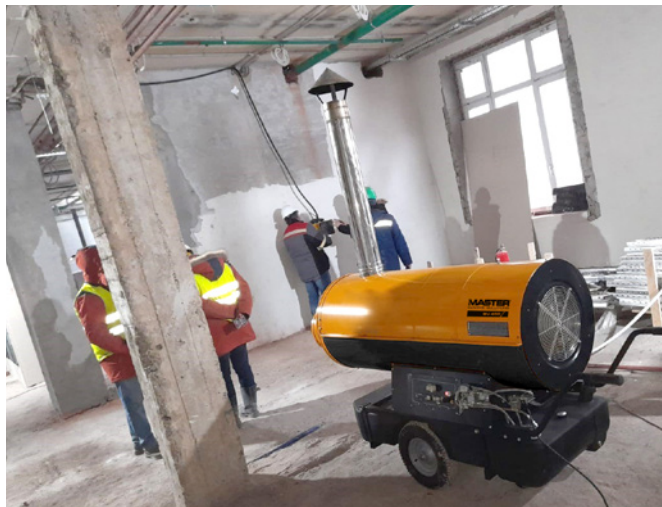
Master BV 400 auf einer Baustelle
