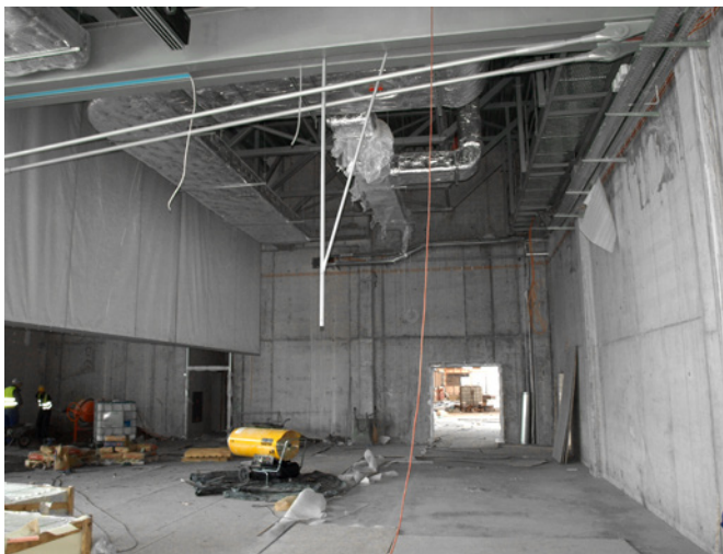
Master B 360 auf dem Bau eines Flughafens
